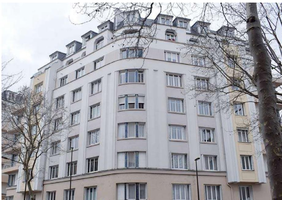
Exemple de rénovation patrimoniale avec application d'enduit isolant à l'aérogel de silice. Bâtiment de 1932. Cette copropriété, adhérente à l'ARC, a reçu un trophée CoachCopro en 2021 pour sa rénovation exemplaire. (photo : ARC)
