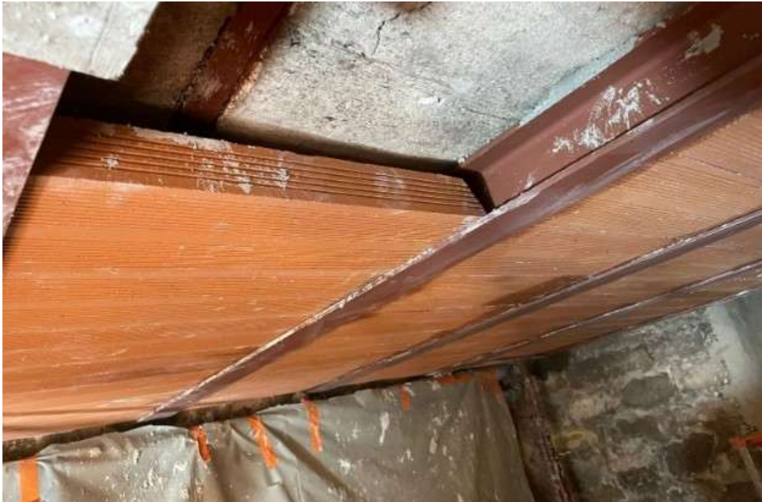
Renforcement par plancher à l'italienne
