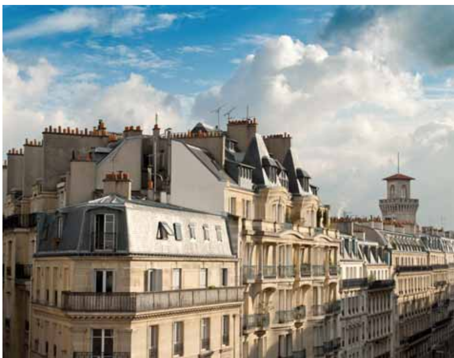
De nombreux copropriétaires voulant optimiser leur achat immobilier et se constituer un revenu complémentaire conséquent mettent en location leur appartement meublé pour de courtes durées sur des plateformes dédiées
