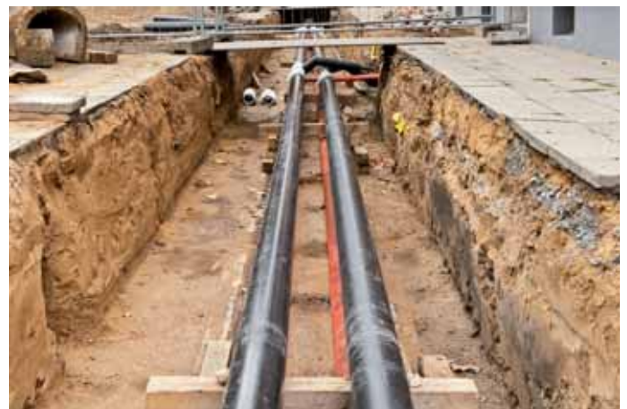
Les fuites d'eau peuvent être difficiles à repérer car les canalisations sont pour la plupart enterrées.
